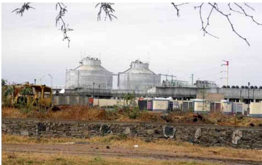
Vista de la planta de tratamiento El Ahogado y los generadores de biogás. Municipio de El Salto, Jalisco.
