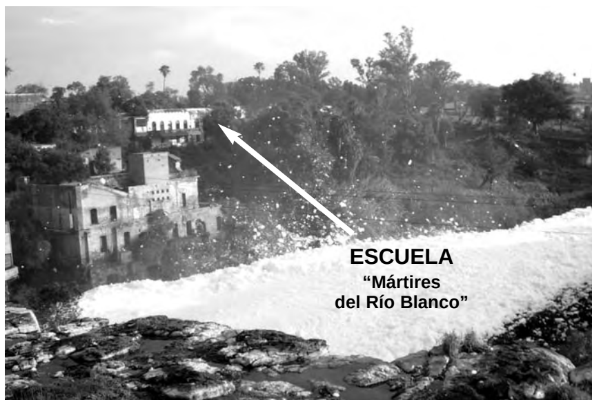
VISTA DE LA ESCUELA DESDE EL PUENTE
