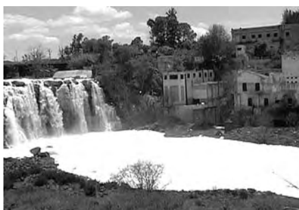
INSTALACIONES DE LA HIDROELÉCTRICA
