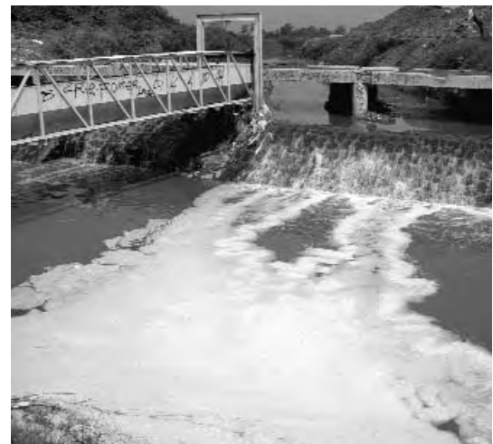
CANAL ARROYO SECO
